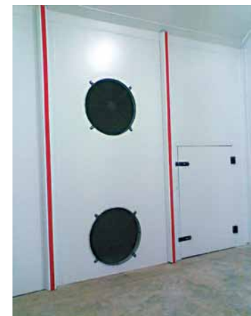
Photo 3 : Chamber construction - plenum
